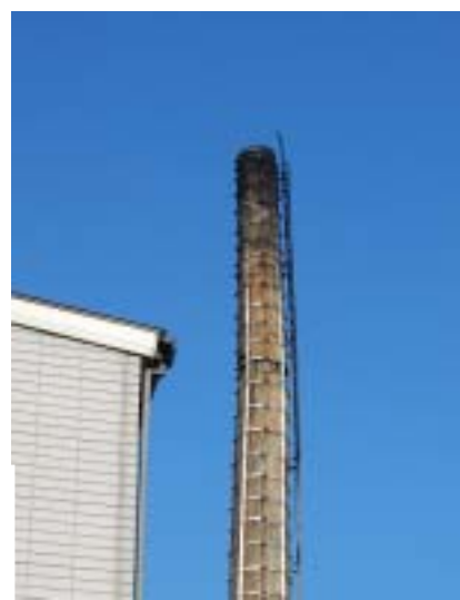
地震のため損傷した山の湯の煙突(写真は3/12撮影)。今は周囲に足場が組まれ、解体工事が開始され、倒壊の危険は解消されています。
